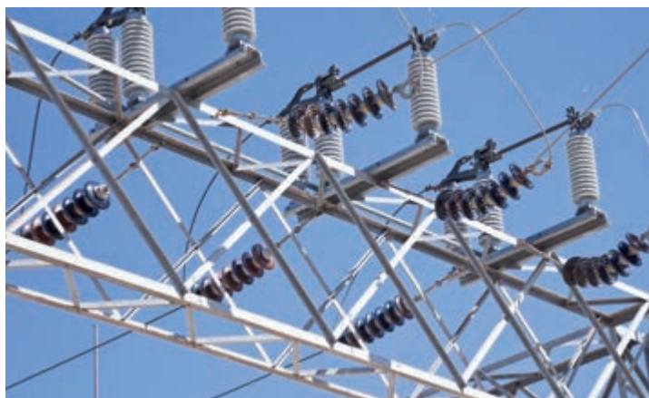
图 5-20 高压输电线路使用了陶瓷绝缘材料
